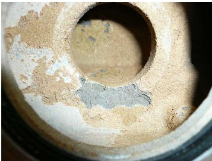
A7 Skorodowana obudowa termostatu z aluminium
