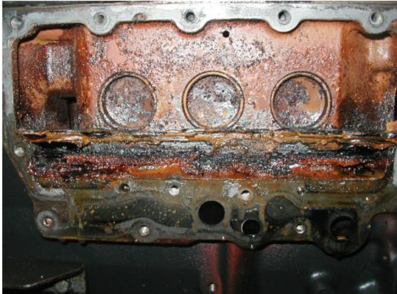
A3 Blok silnika w obszarze chłodnicy oleju silnikowego
